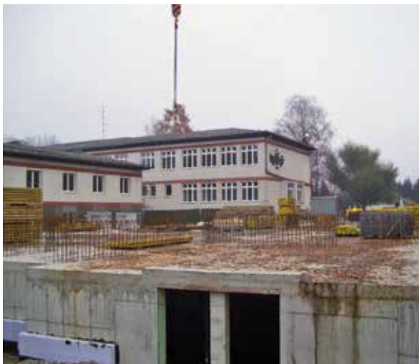
Neubau NMS Lieferung, 1. Baustappe 2012.
