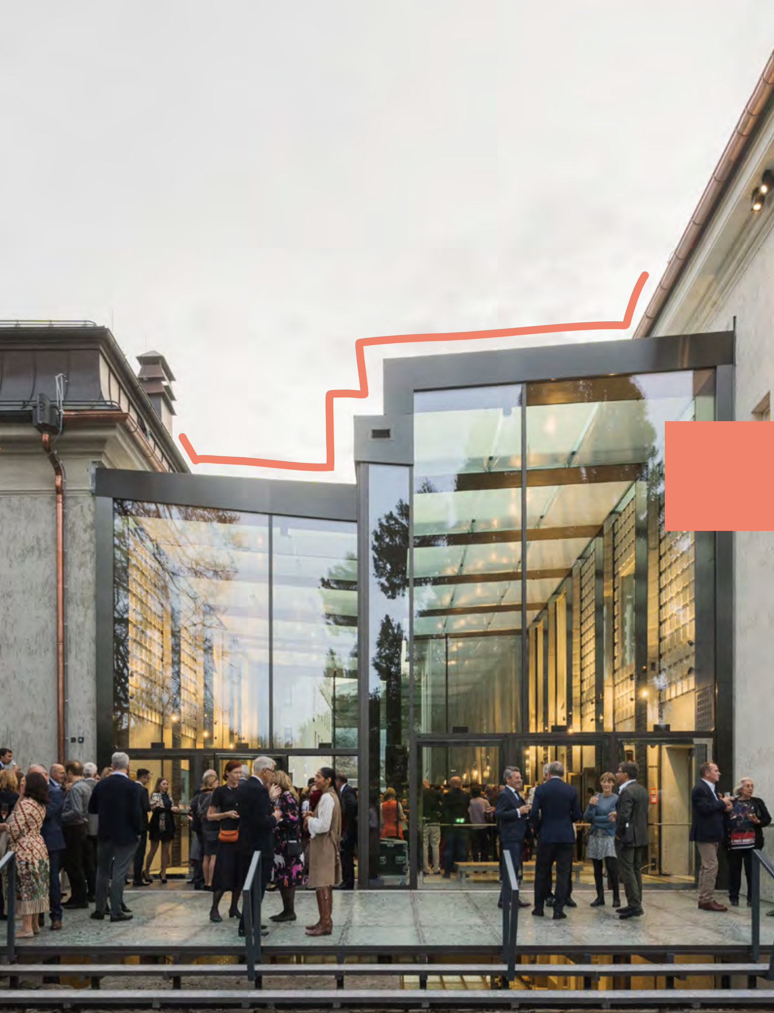
Nach zweijähriger Bauzeit wurde 2022 die Neugestaltung des Pausenfoyers der Stiftung Mozarteum fertiggestellt. Eine filigrane, luftig helle Konstruktion aus Stahl und Glas verbindet nun die zwei denkmalgeschützten Gebäudeteile und schafft neuen Raum.
