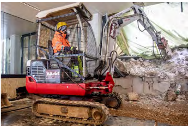
Aufräumarbeiten und Abtransport der Gesteinsbrocken nach dem Felssturz
