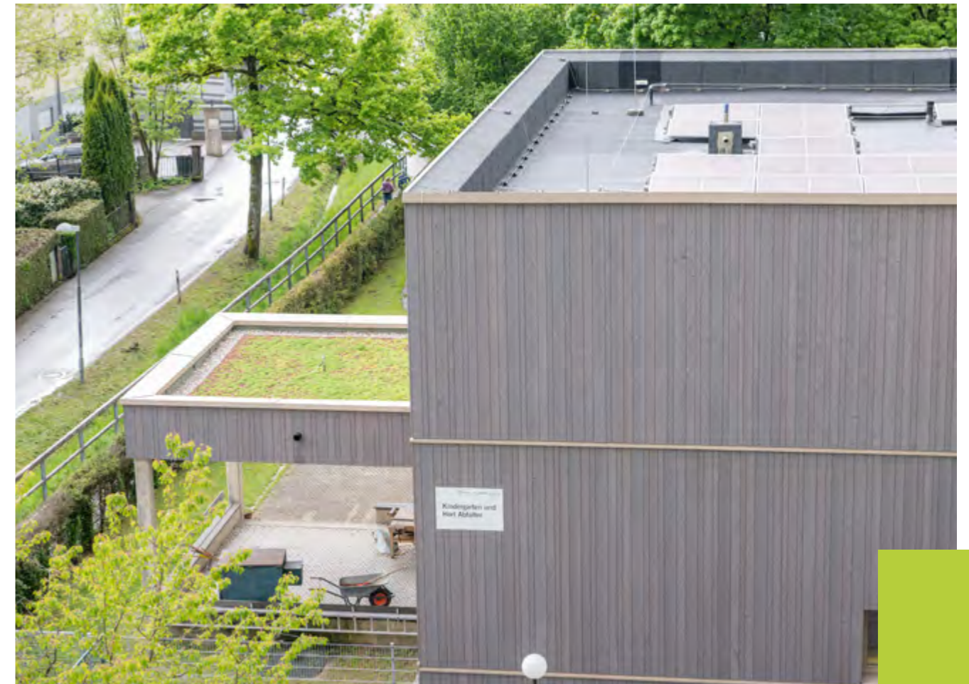
Die neue, hinterlüftete Holzfassade des Kindergartens Abfalter ist nur eine der Erneuerungen, die im Zuge der Sanierungsarbeiten vorgenommen wurde
