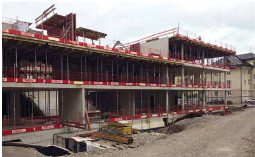
Bildungscampus Gnigl, Bauphase
