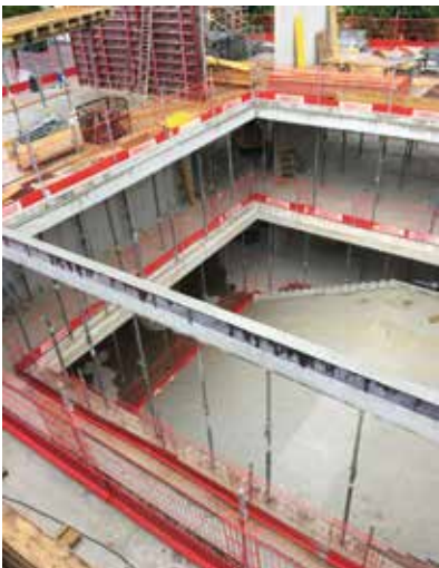
Bildungscampus Gnigl, Bauphase
