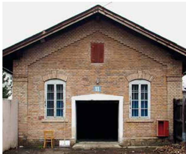
Architekturhaus. Backsteingebäude Riedenburg vor dem Umbau
