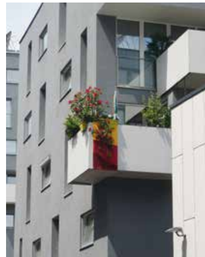
Projekt v. Anton Thiel am Stadtwerk-Areal – Stadtwerk-Preis für Balkon1a
