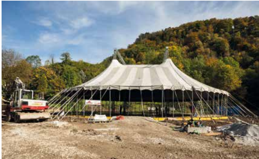
Errichtung Cirkustrainingszentrum Gnigl
