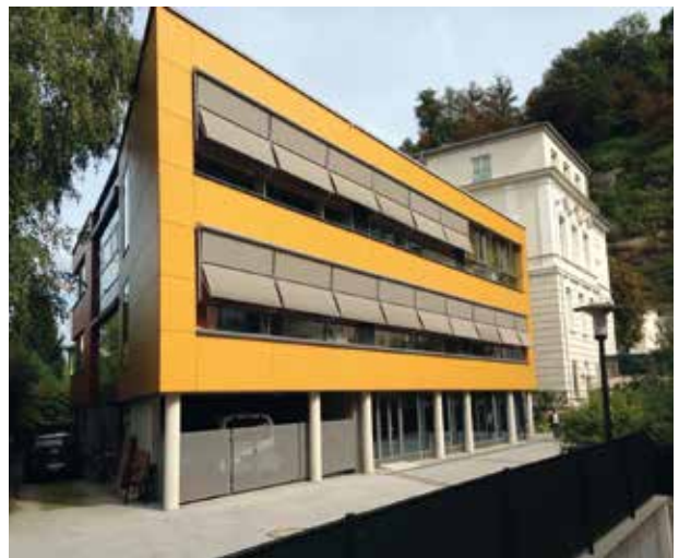
VS Mülln, Garderobenneubau, Außenansicht
