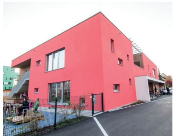
Neuer Kindergarten Riedenburg, Außenansicht
