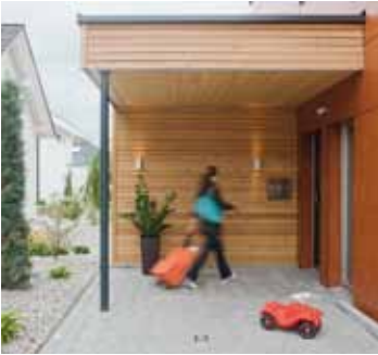
Ein überdachter Hauseingang bietet Schutz vor Wind und Wetter, und gute Beleuchtung schafft mehr Sicherheit.
