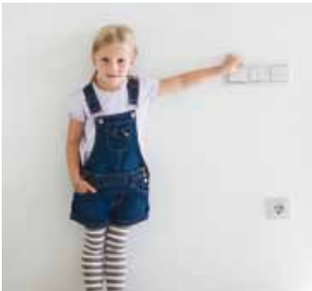
Lichtschalter so montieren, dass alle in der Familie sie bedienen können, auch die Steckdose in gut erreichbarer Höhe von 40 cm anbringen.
