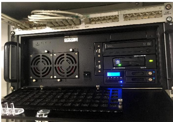
**Die neue Dokumentationsanlage ermöglicht die Aufzeichnung IP-basierter Gesprächsdaten („Voice over IP“)**
