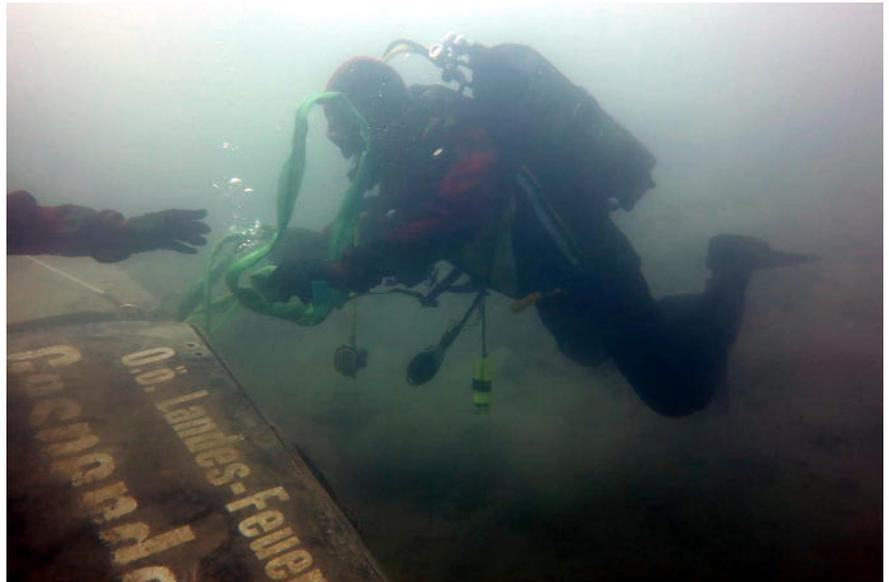
**„Arbeiten unter Wasser“ - Anbringen eines Hebeballons an einem Übungsfahrzeug**
