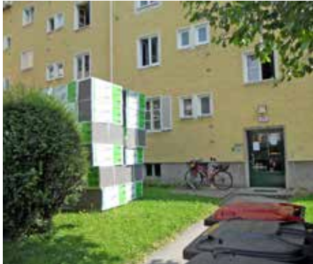
Die Sanierung der insgesamt 14 Wohnhäuser in der Strubergassensiedlung wurde im Herbst 2013 termingerecht abgeschlossen.
