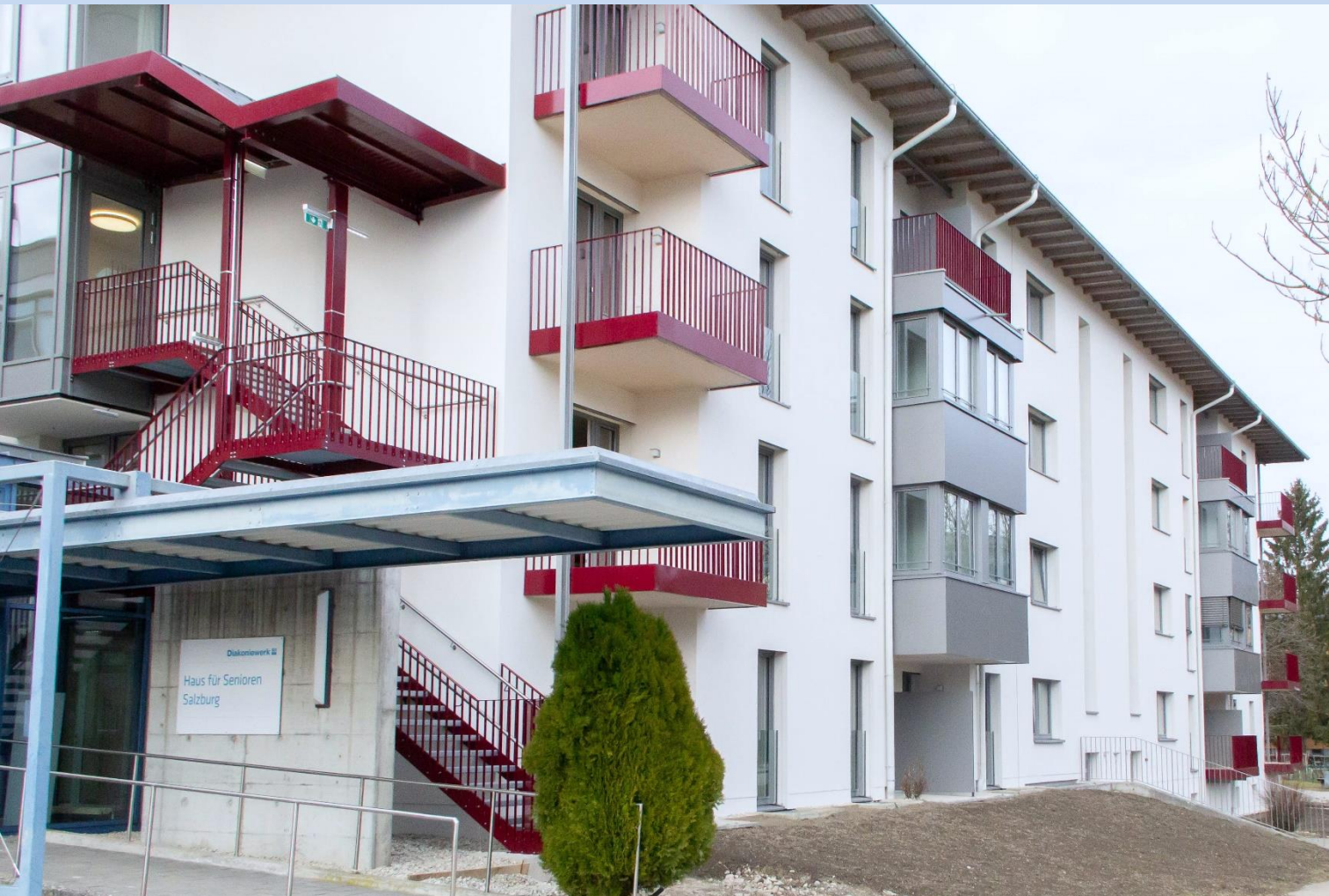
Seniorenwohnhaus „Itzling - Haus 3“
