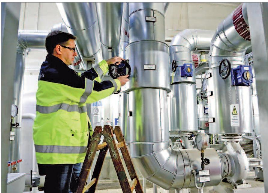
*Das neue Wärmekonzept der SALK nutzt den Standortvorteil des nahe gelegenen Heizkraftwerkes Mitte. Unter der Salzach hindurch wird Hochtemperatur-Prozesswärme und Nieder-temperatur-Fernwärme an das Krankenhaus geliefert.*
