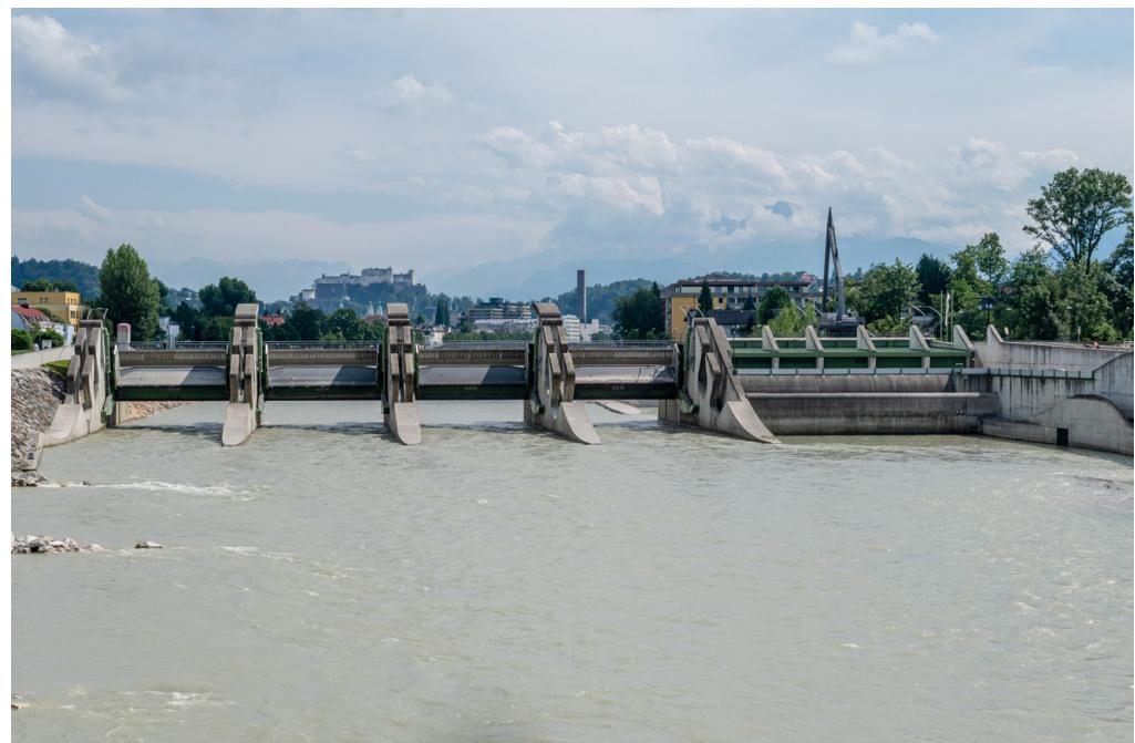
Abbildung 5.15: Laufkraftwerk Sohlstufe Lehen; Quelle: Magistrat Salzburg, Killer 2021
