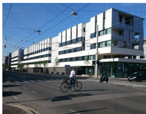
Abbruch und Neubau von Wohnungen an der Rudolf Biebel Straße, Bezug 2016
