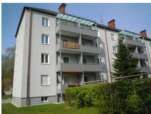
Sanierter Bestand in der Strubergassensiedlung
