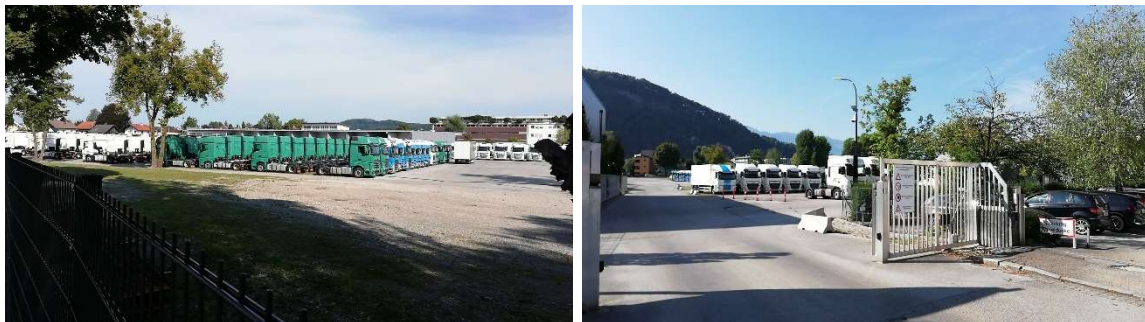
Abbildung 5-13: Blick auf die Prüffläche Nr. 11 von Süden aus Richtung Norden (linkes Bild) und von Norden aus Richtung Süden (rechtes Bild)
