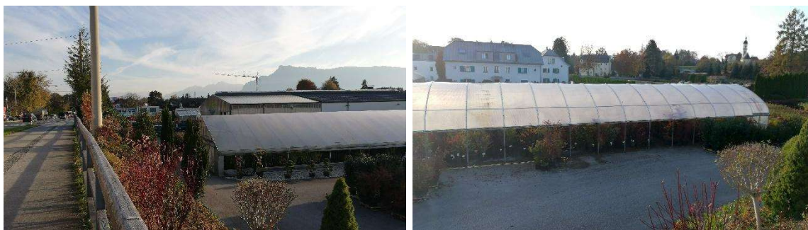
Abbildung 5-36: Blick auf die Prüffläche Nr. 31 von Osten aus Richtung Süden (linkes Bild) und Westen (rechtes Bild)
