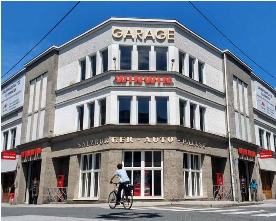
Abbildung 7: Ehemaliger „Autopalast“ im Stadtteil Schallmoos. Es besteht Potential der Nachverdichtung mit geförderten Wohnungen. Stellplätze müssten nicht neu errichtet werden. Das Erdgeschoß ermöglicht flexible Nutzungen. Im Wohnumfeld könnten Stellplätze weiter reduziert werden, um den öffentlichen Raum lebenswerter zu machen; Quelle: SIR
