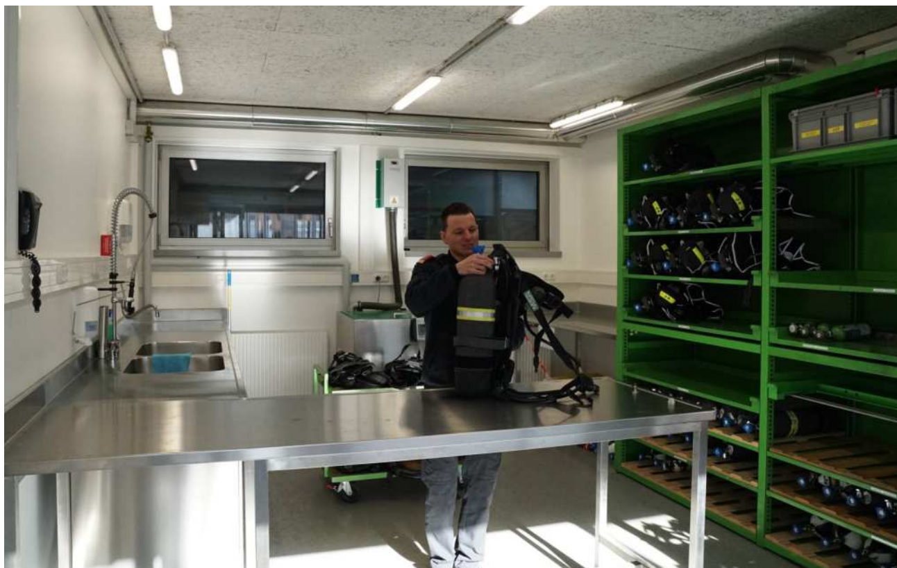
Vorreinigung eines Pressluftatmers im neuen Reinigungsbereich der Atemschutzwerkstätte
