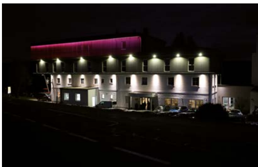
Abb. 40: eine normgerechte Objektbeleuchtung wirkt in einer dunklen Umgebung sehr hell und ist somit für die optimale Wahrnehmung nicht erforderlich (Hotel Alpenblick, Kirchschlag bei Linz, OÖ)
