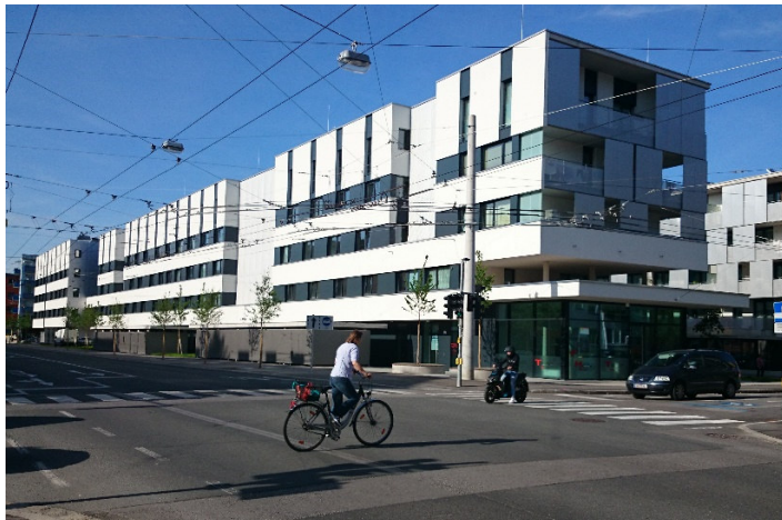
Abbruch und Neubau von Wohngebäuden an der Rudolf Biebelstraße im Zuge der Quartierssanierung Strubergassensiedlung.
