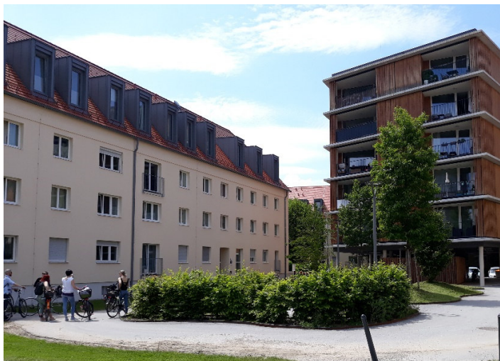
General-Keyes-Straße: Sanierung mit Dachbodenausbau und Nachverdichtung mit solitären Holzbauten.
